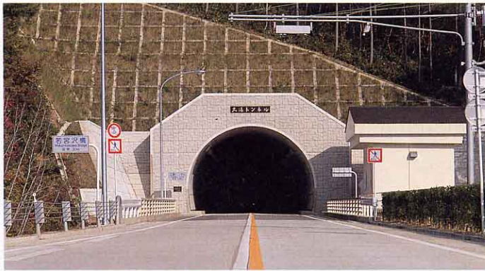
・115号土湯トンネル
