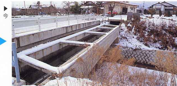
▲ 1982年に見つかったかがりのあと トンネルをほるのがむずかしかったので、川のがけにそって木のといをのせて用水をひいてきましたが、川岸のため何度も大水で流されました。㊸
