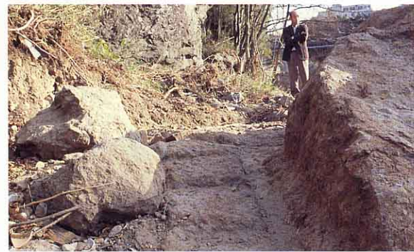
▲ 1982年に見つかったかがりのあと トンネルをほるのがむずかしかったので、川のがけにそって木のといをのせて用水をひいてきましたが、川岸のため何度も大水で流されました。㊸
