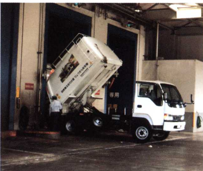
▲ごみピットに入れる
