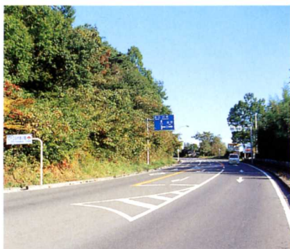
▲国道114号線柴切田付近
