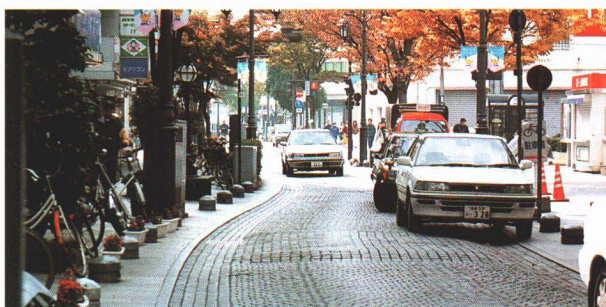
▲車がスピードを出せないようにカーブをつけた道路 (パセオ470)
