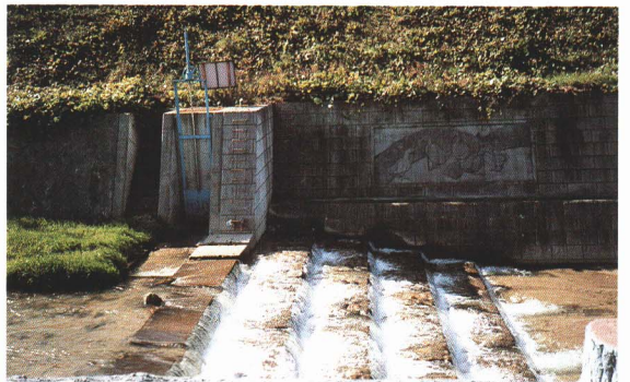
▲広瀬川改修後の勘左閼の様子
