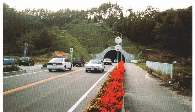
▲川俣トンネル 福島への交通をよくするため、国道114号バイパスに作られました。
