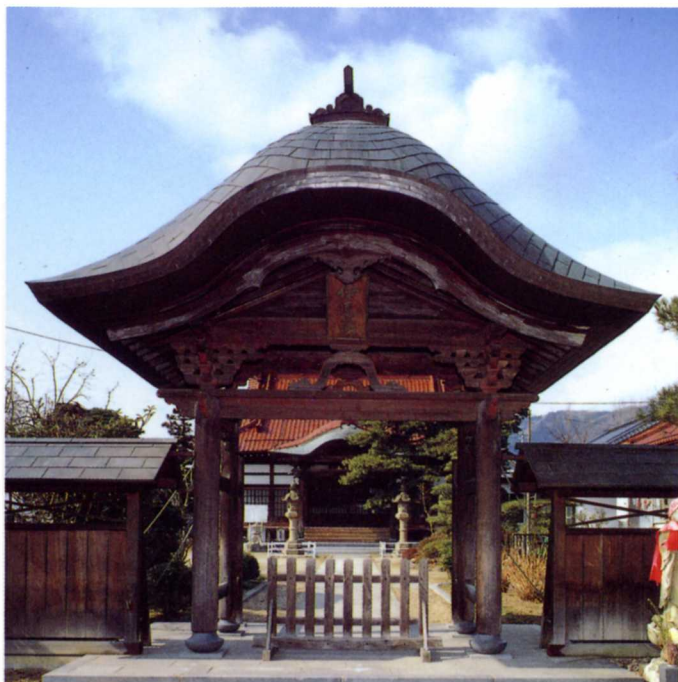
桑折寺山門 (伊達家ゆかりのお寺) (500年くらい前) 重要文化財 (県)
