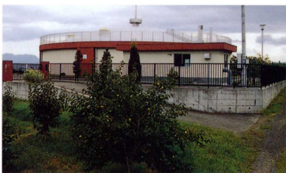
はいすいち 配水池 (平沢)
