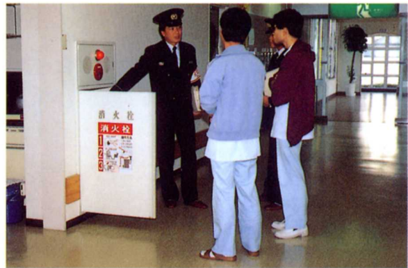
消火栓の点検
