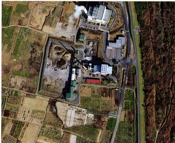
伊達地方衛生処理組合清掃センター
