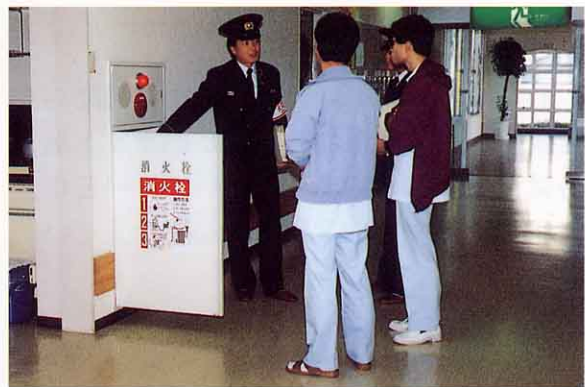
消火栓の点検
