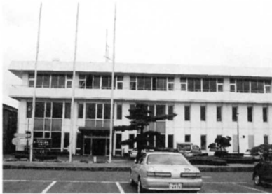
農村環境改善センター（中央公みん館）
