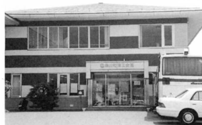
梁川町商工会館
