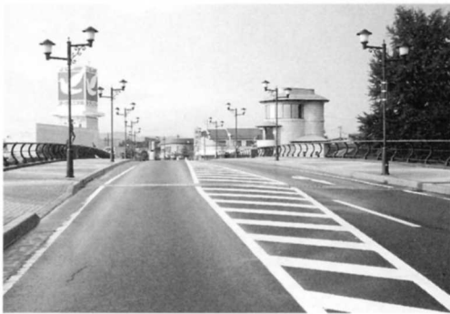
梁川地区 広瀬橋
