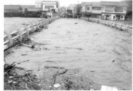
冠水した広瀬橋
