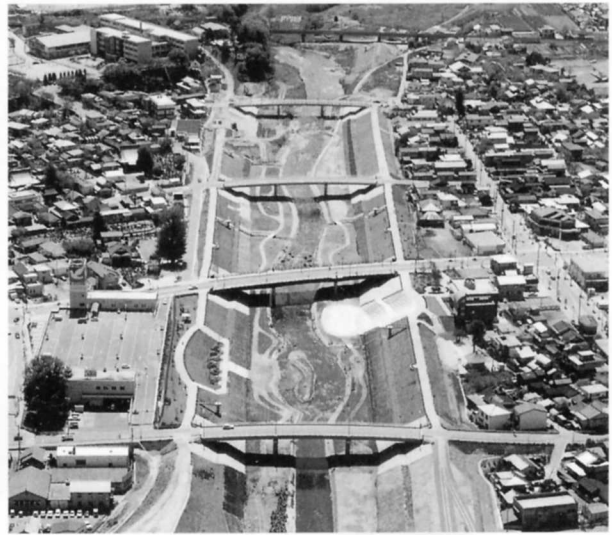
改修後の広瀬川（平成8年）
