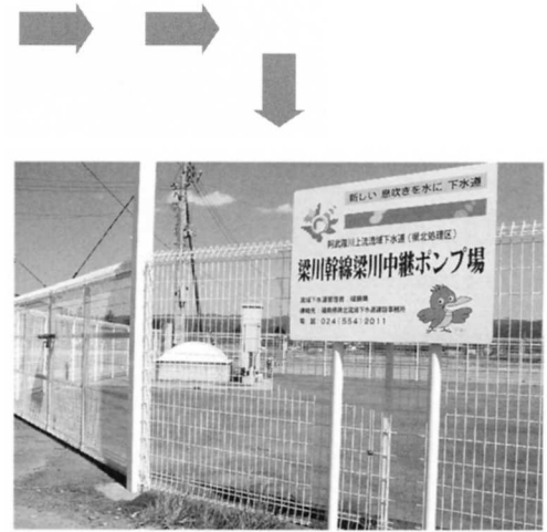
▲中継ポンプ場
