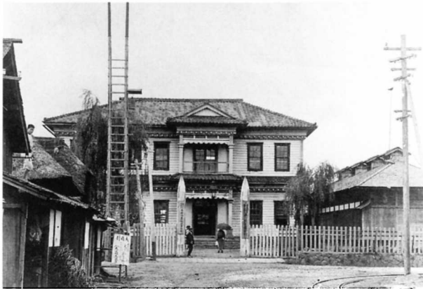
梁川町の古い役場（梁川地区）
