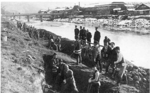
広瀬川の堤防工事
