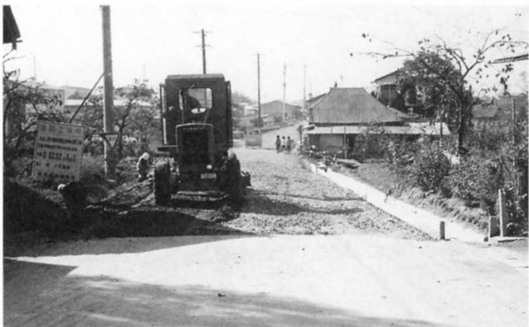
町内道路の舗装工事
