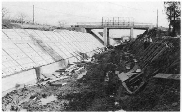
丸森線梁川分工事着工
