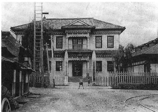
梁川町の古い役場（梁川地区）
