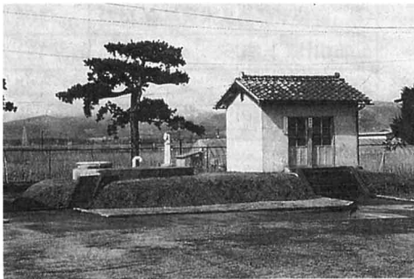
水道の水げん地 (梁川地区)
