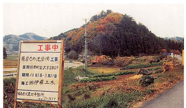
▲ ため池を使いやすくするための工事も行なわれます。
