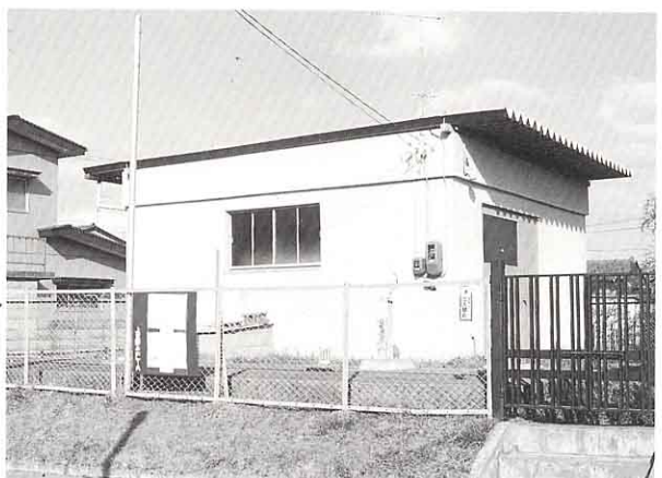
▲ 高子団地ポンプ室
