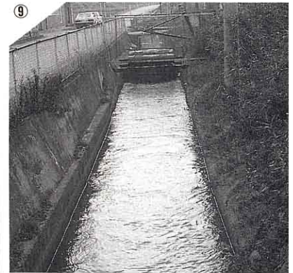
▲ 水量の調節 砂子堰はたいへんこう配がゆるいので、水量を調節し、流れがとどこおらないようにしています。
