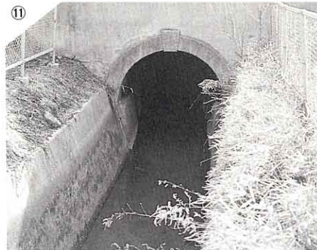
▲ 文知摺付近トンネル
