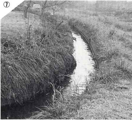
▲ 曲がりくねった水路 土地のようすに合わせて、水路が大きく曲がっているところもあります。(梁川町細谷)
