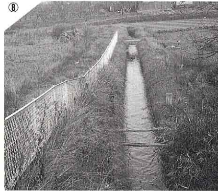
▲ 整備された水路 三面をコンクリートにし、まっすぐに通されている水路です。
