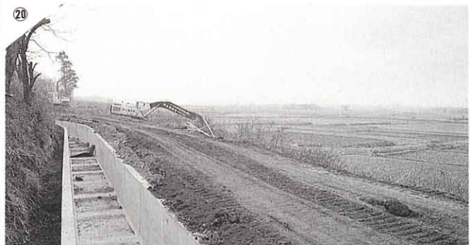
▲ 現在はコンクリートの水路にかえられています。
