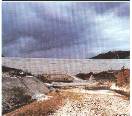
けんせつ すりかみ 建設中の摺上川ダム
