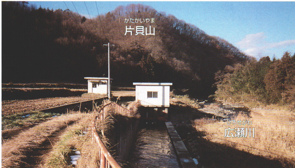
<砂子堰の取り入れ口>
