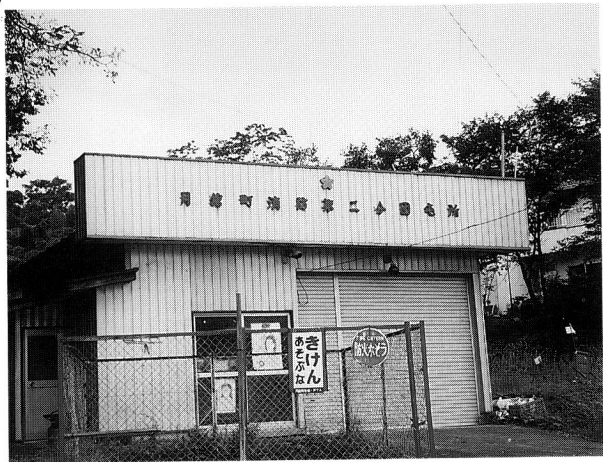
(防火水そうとポンプおき場)
