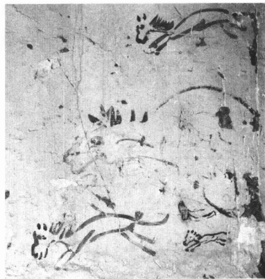
立子山天正寺の落書き（本堂外壁）
