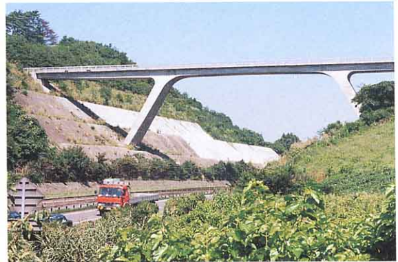
▲山ノ入水路橋（東北自動車道の上をわたる）
