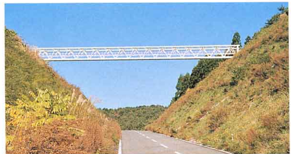
▲板ばしの水管橋（新しくできる農道の上をわたる）
