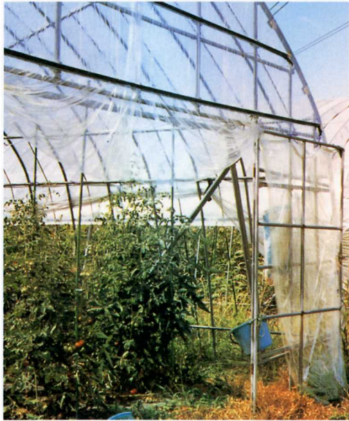
(チェリートマトのビニールハウス)
