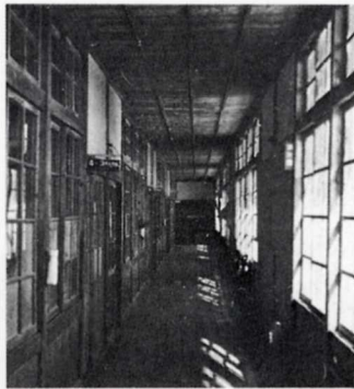
(木造校舎の内部)
