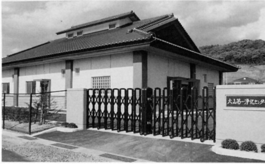
(大山第1 じょうけつ 浄化センター)
