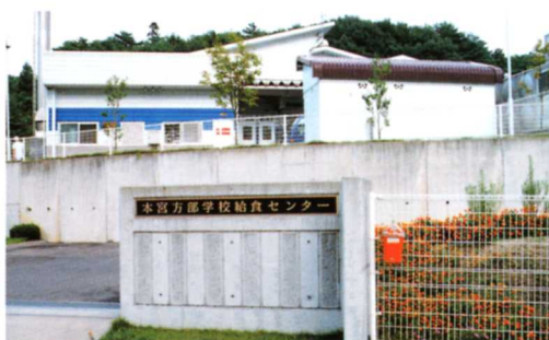
④ 本宮方部学校給食センター きょうしよく
