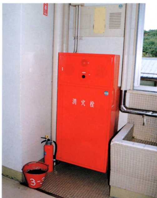
しょうか しょうか き ぼうかすな 消火せんと消火器，防火砂
