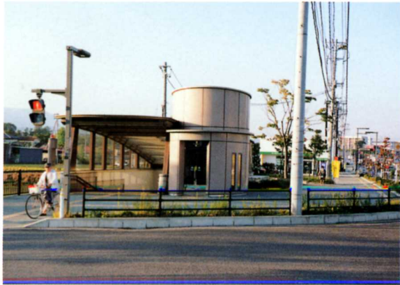
自転車も通れる地下歩道と広い歩道 ちかほどう
