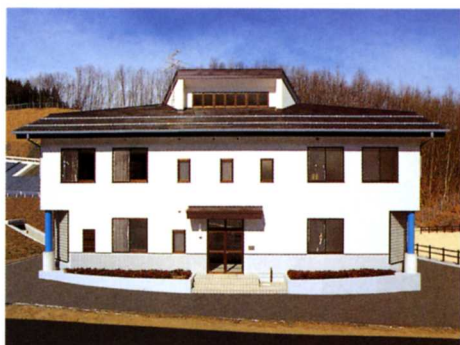
浸出水処理施設
