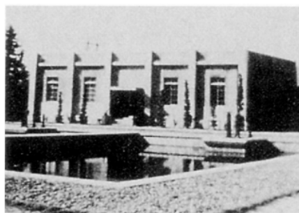
旧高木浄水場
