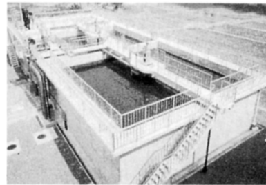
せんじょうはいすいち 洗浄排水池、 はいでいち 排泥池、 のうしやくそう 濃縮槽
