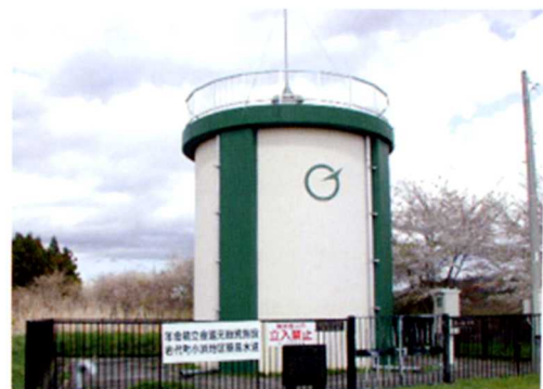
はいすい 配水池 (小浜字下館)
