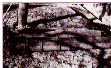
① 多田野水道の木管
