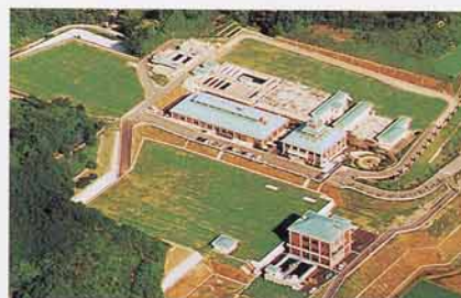
新しくつくられた荒井じょう水場
