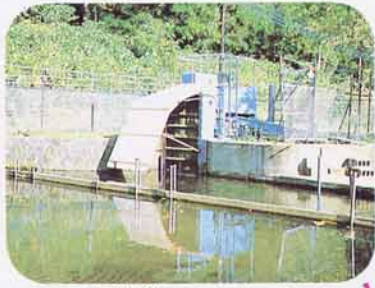
ふかざわ 深沢川取水場
