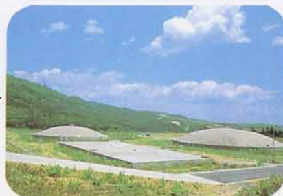
じょうすいち はいすいち じょう水池・配水池
