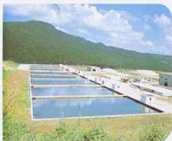
かんぜん かち 緩速ろ過池
