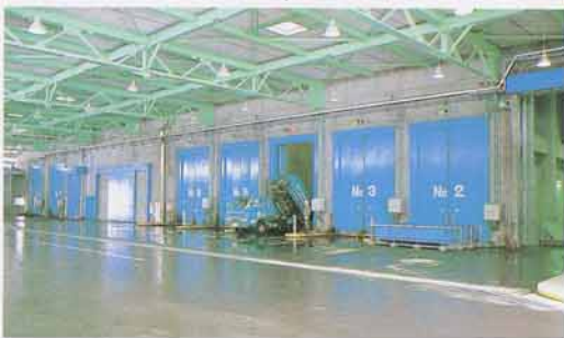
プラットホーム ここでごみをピットの中に入れます。
