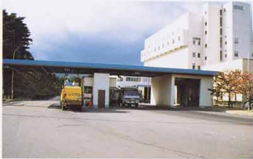
けいりょうき ごみ計量機 ここで、ごみの量をはかり記録します。
