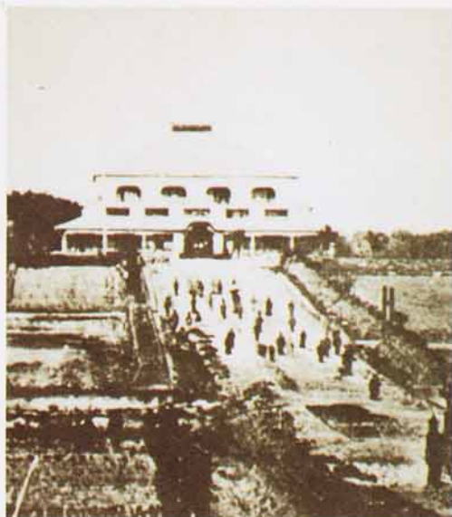
けんせつ 建設されたばかりの開成館
