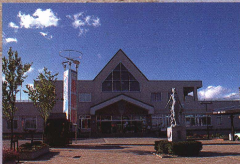
須賀川駅舎(コミュニティプラザ併設)
