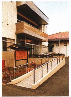
障害者などにやさしいスロープ
